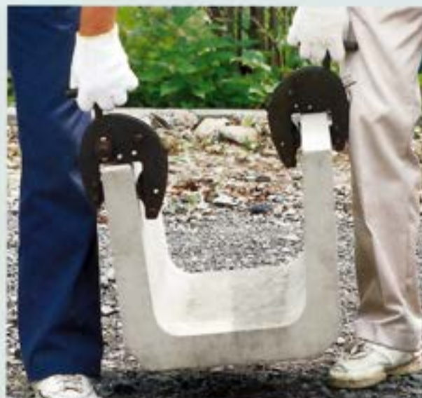
▲手吊り作業中(写真はS-150です)
